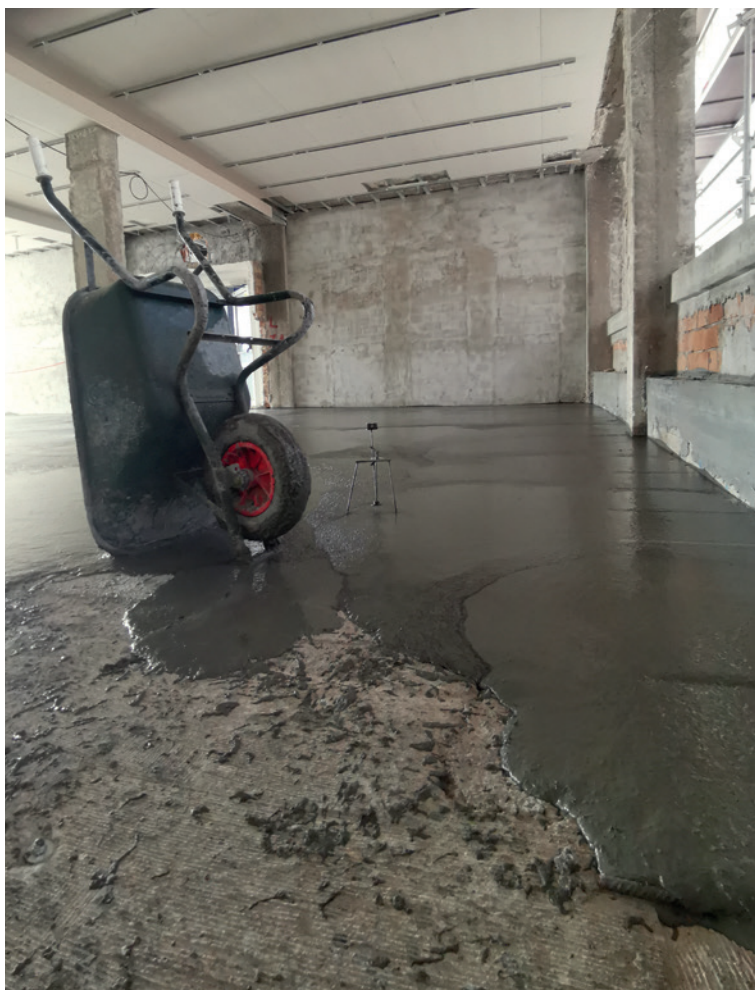
Rinforzo estradossale del solai con calcestruzzo HPFRC MicroGold Steel Ruregold.
