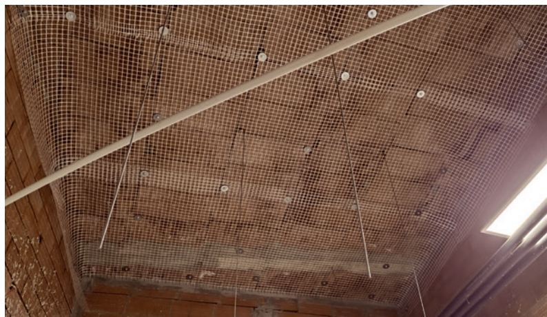
Presidio di sicurezza con rete SafeNet posato a secco con Tasselli CLS.
