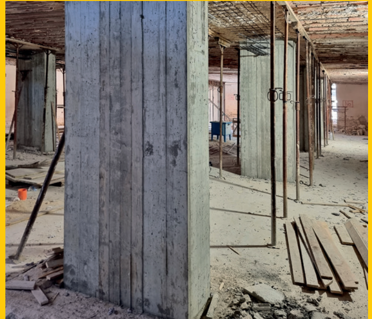
Incarniciatura del pilastro "Jacketing" con Compat Gras Calce (Rck 45 MPa).
