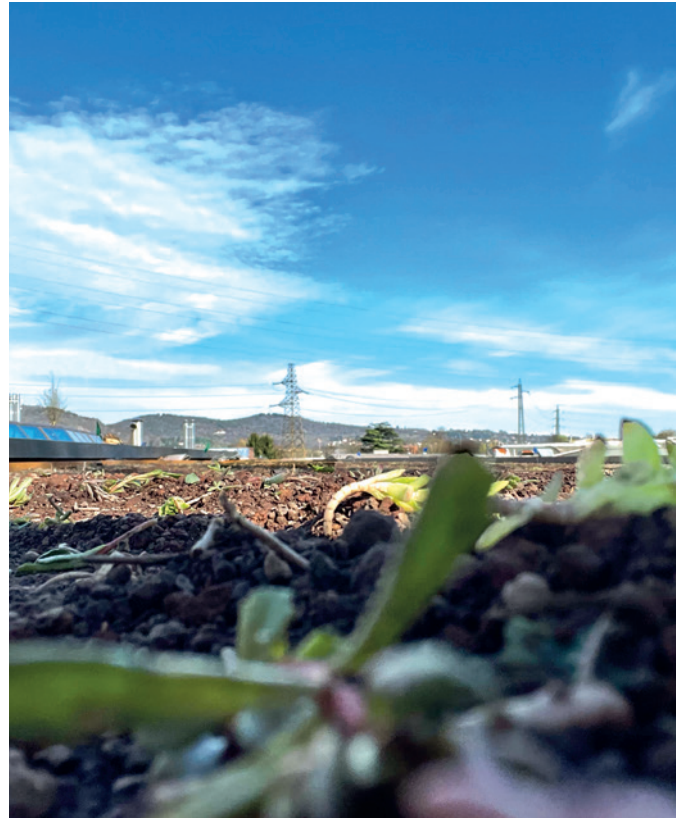
Un particolare della messa a dimora delle piante di Sedum.
