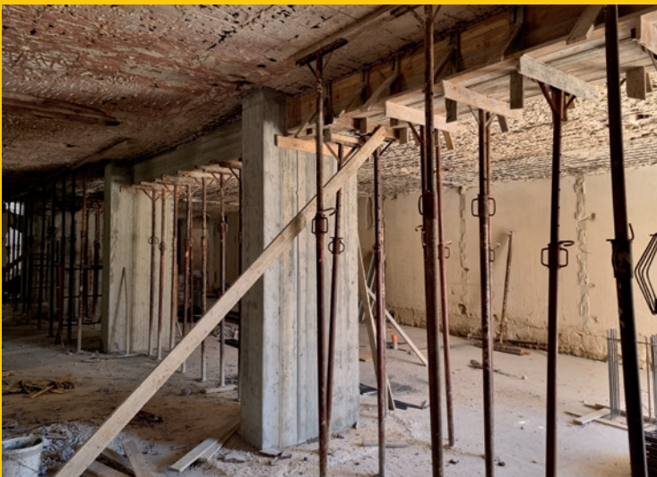
Casseratura delle travi durante il getto di calcestruzzo Compat Gras Calce.
