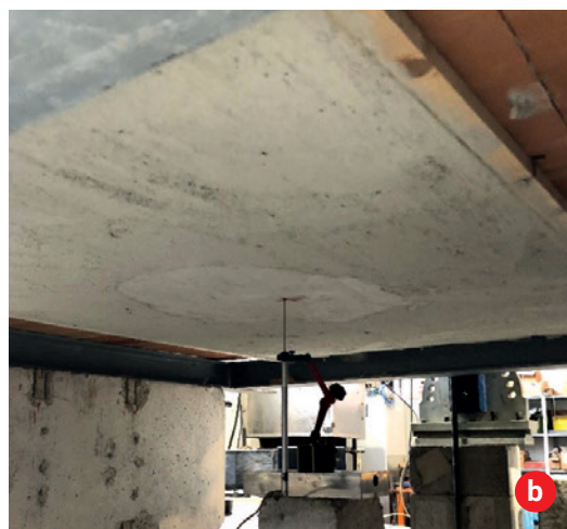
Applicazione del sistema di rinforzo tramite malta cementizia: a) fase di ancoraggio con dispositivi di connessione; b) fase di finitura con malta.
