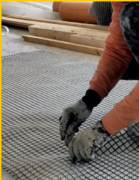
Taglio della rete C-MESH 42/42 a misura.
