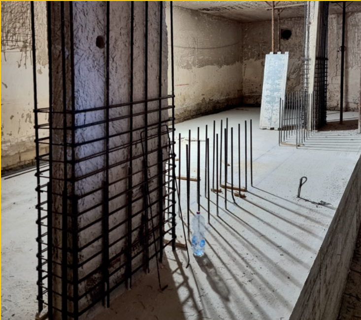
Posizionamento della nuova armatura.
