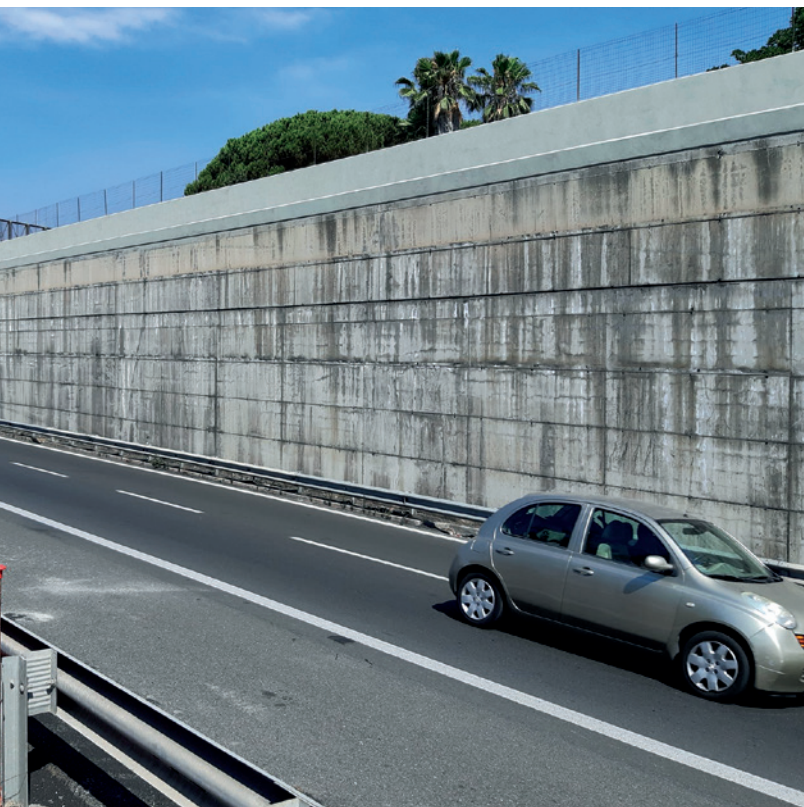
Parete in calcestruzzo prima dell'intervento di mitigazione acustica.
