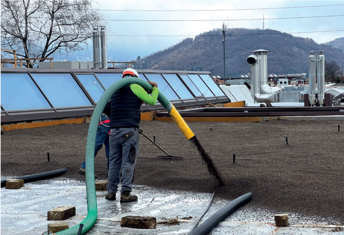
Pompaggio in quota dell'argilla espansa AgriLeca.
