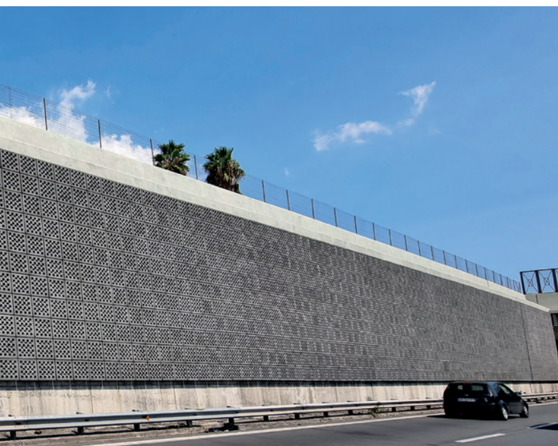
Intervento di mitigazione acustica con Lecablocco Fonoassorbente FonoLeca Quadro.
