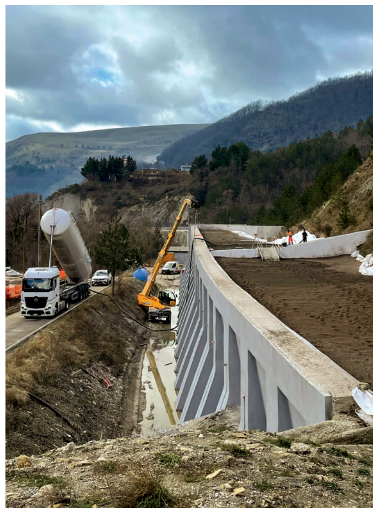
Esempio di realizzazione di galleria paramassi a Gubbio (PG): l'argilla espansa Leca è stata pompata in quota per velocizzare la realizzazione.
