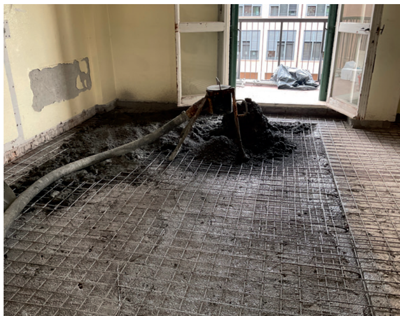
Posa della soletta collaborante in LecaCLS 1400 CAM dopo la stesura del Connettore Chimico CentroStorico.
