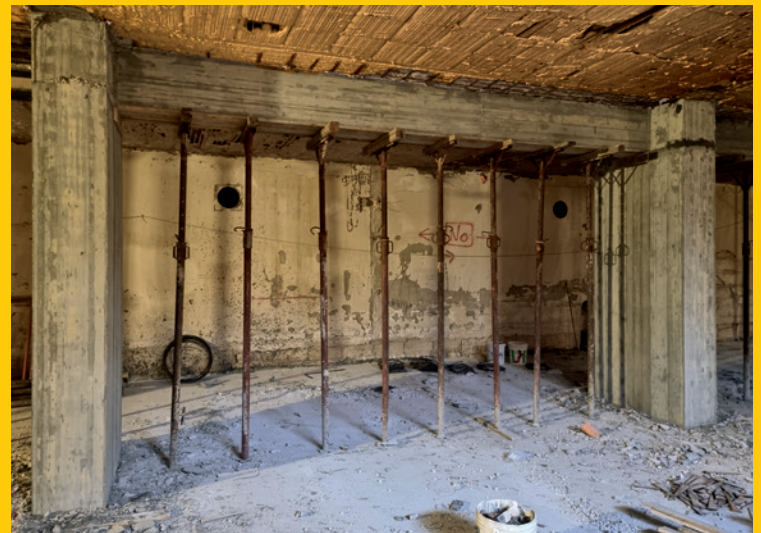
Trave ringrossata con calcestruzzo Compat Gras Calce (Rck 45 N/mm 2 ).
