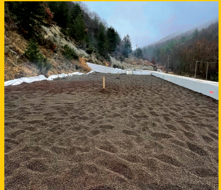
Materassino assorbente in argilla espansa per la caduta dei massi a Gubbio (PG).
