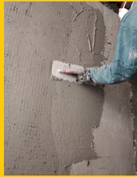
Stesura del secondo strato di malta tecnica MX-C 25 Muratura.
