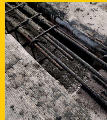
Getto di travi e cordoli strutturali con Ultrabeton Gras Calce.
