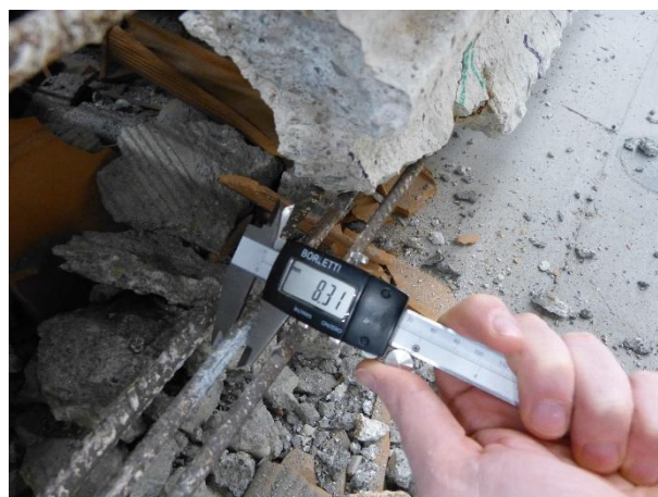
Figura 8 Particolare dell'armatura inferiore del travetto da 4.00 m
