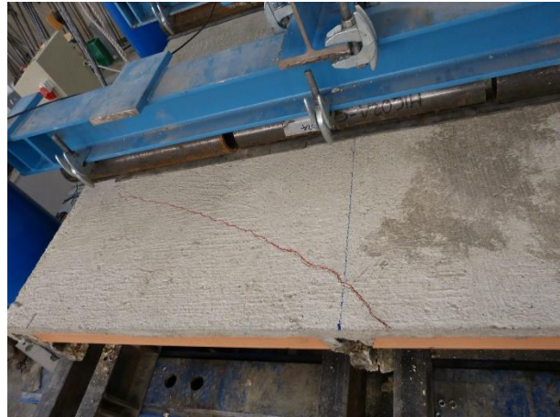
Figura 69 Dettaglio di una fessura obliqua formatasi nella cappa dopo il collasso del travetto 1
