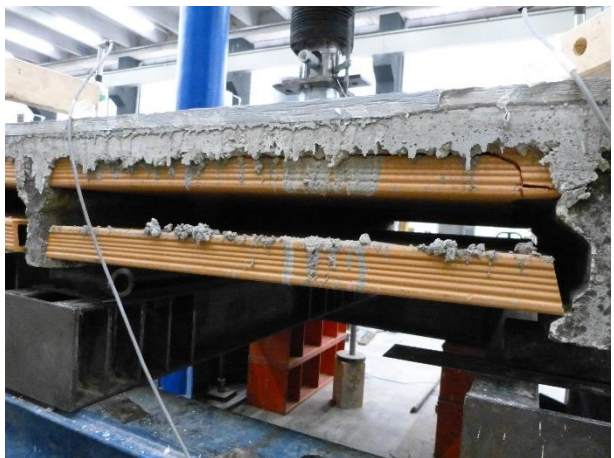
Figura 158 Condizioni delle tavole ad inizio prova (rottura per ritiro contrastato della cappa collaborante)
