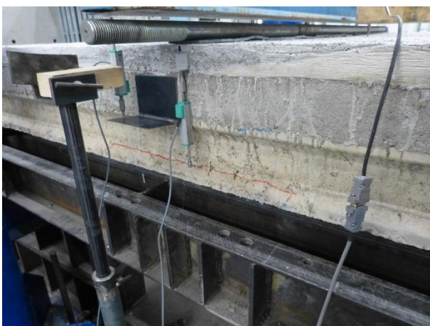
Figura 138 Quadro fessurativo del travetto 1 prima di iniziare la prova
