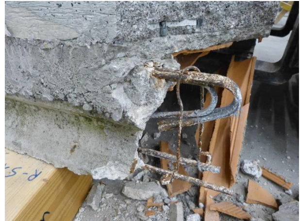
Figura 10 Dettaglio dell'armatura all'estremità dei travetti
