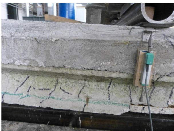
Figura 178 Dettaglio della formazione della cerniera plastica nel travetto 1
