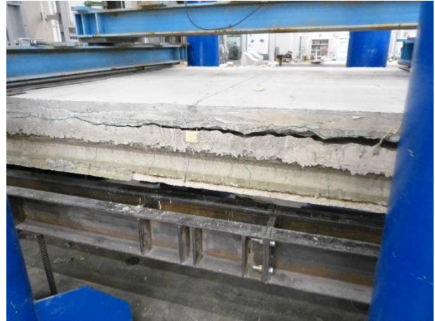
Figura 116 Propagazione della fessura a taglio nella porzione centrale del travetto 1
