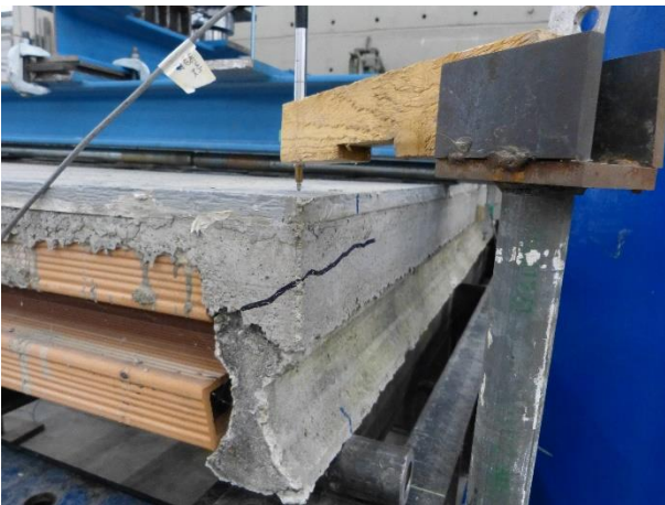
Figura 92 Condizioni dei travetti a inizio prova (fessure evidenziate in nero)
