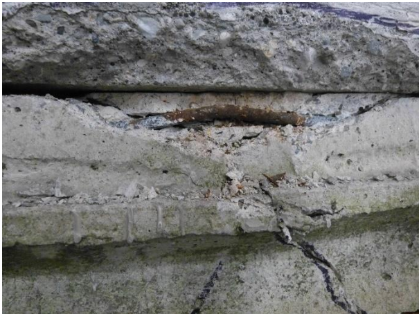
Figura 183 Dettaglio del collasso per instabilità della barra superiore del travetto 1 in seguito all'espulsione del calcestruzzo della cappa (come avvenuto nelle prove sui singoli travetti)
