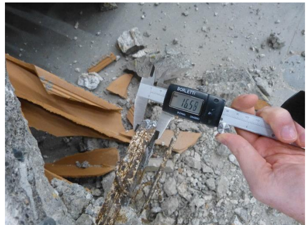
Figura 12 Particolare dell'armatura superiore dei travetti lunghi
