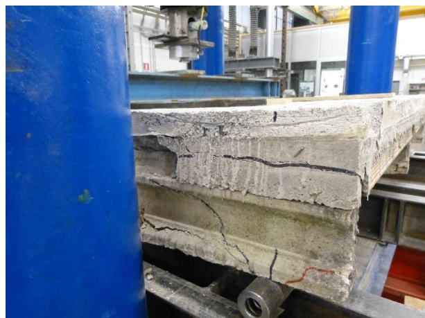
Figura 150 Condizioni dell'appoggio destro del travetto 1 a fine prova
