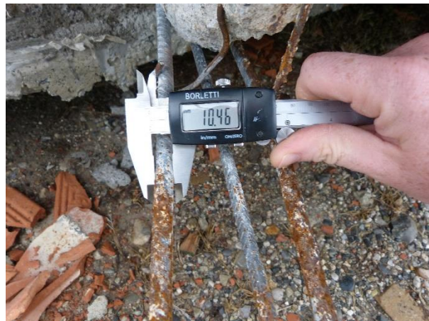
Figura 4 Particolare dell'armatura inferiore del travetto da 4.25 m
