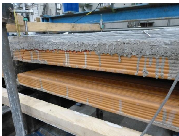
Figura 152 Dettaglio delle rotture per trazione nelle tavelle in laterizio (condizione pre-prova)
