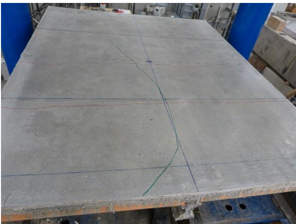
Figura 101 Quadro fessurativo della cappa a fine prova (rosso pre-prova, verde post-prova)
