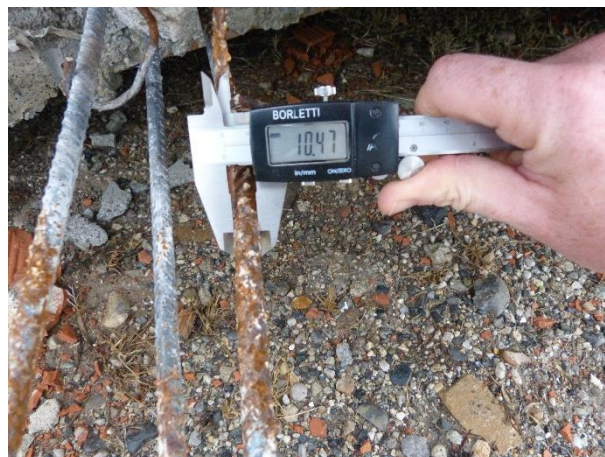
Figura 6 Particolare dell'armatura inferiore del travetto da 4.25 m
