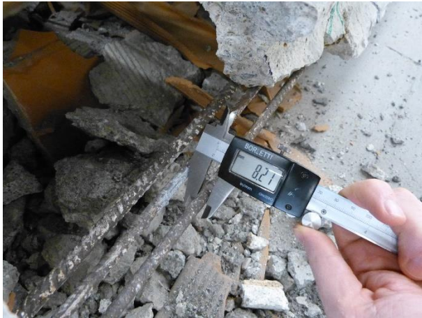
Figura 9 Particolare dell'armatura inferiore del travetto da 4.00 m
