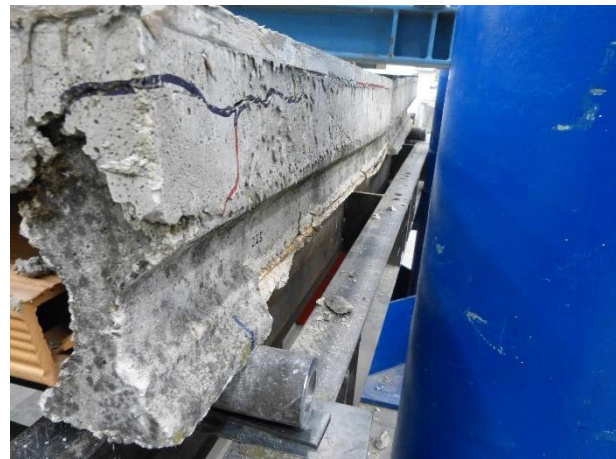
Figura 167 Condizioni dell'appoggio sinistro del travetto 1 a fine prova
