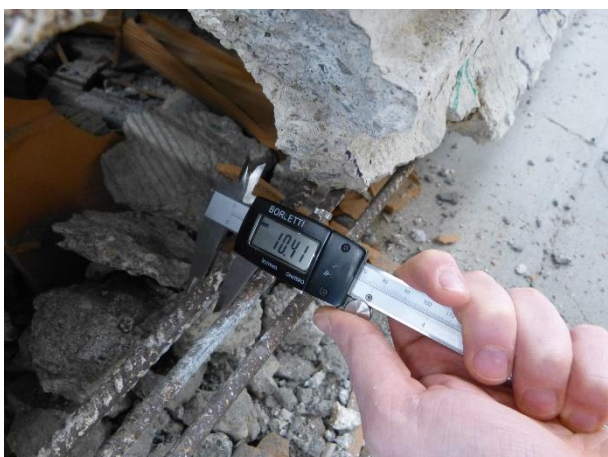
Figura 7 Particolare dell'armatura inferiore del travetto da 4.00 m
