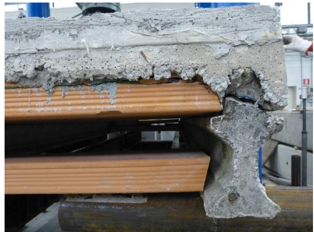
Figura 118 Condizioni dell'appoggio destro del travetto 3 a fine prova
