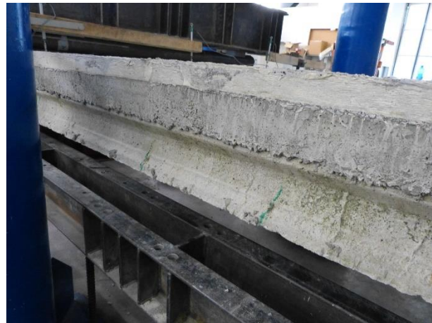
Figura 170 Condizioni del travetto 31 ad inizio prova (in verde vengono segnate le fessure preesistenti)
