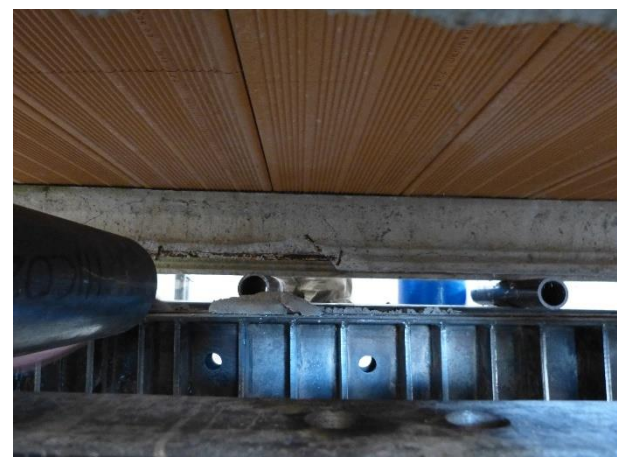
Figura 120 Condizione generale del travetto 3 a fine prova
