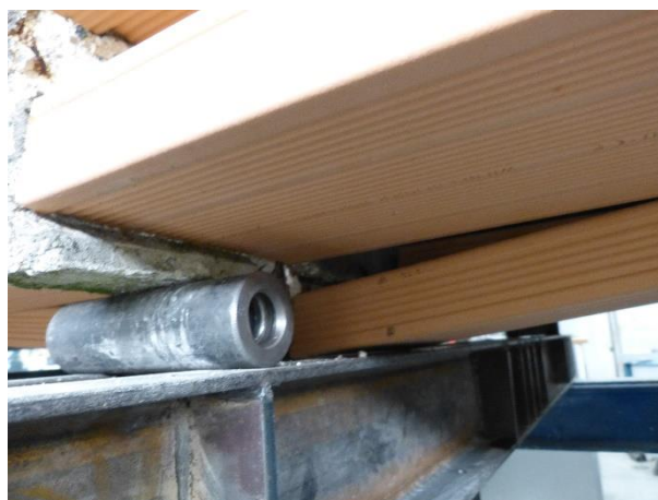
Figura 67 Collasso delle tavole inferiori in seguito al collasso per taglio del travetto 2 (centrale)
