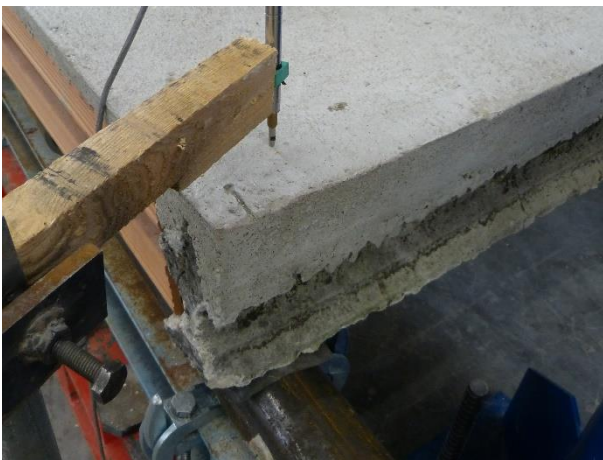
Figura 121 Dettaglio degli appoggi in cui si può osservare la condizione del travetto prima della prova
