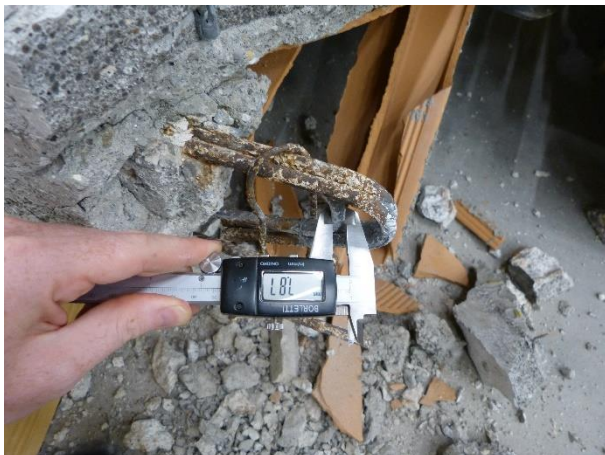
Figura 11 Particolare dell'armatura superiore dei travetti lunghi
