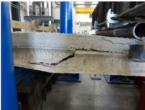
Figura 132 Fessura a taglio nel travetto 1 che ha portato alla perdita di capacità portante del solaio
