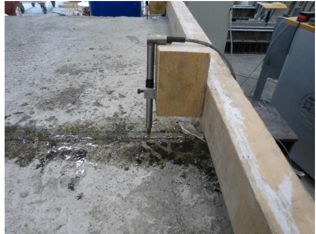
Figura 126 Dettaglio della fessura formata in fase di trasporto del provino e successivamente riparata con resina epossidica bicomponente
