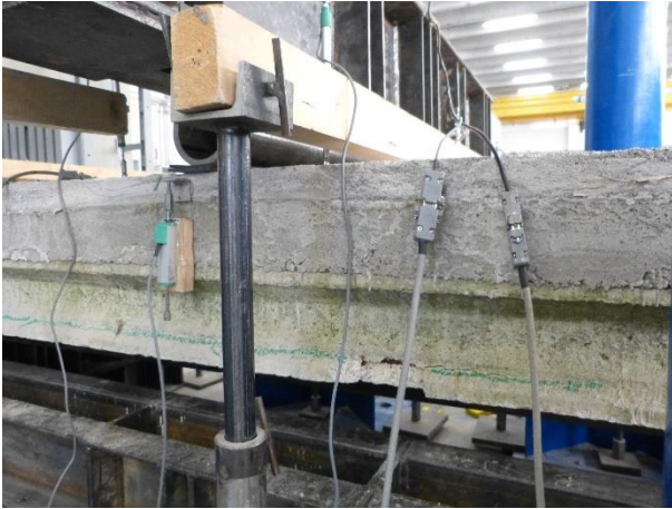
Figura 171 Condizioni generali del travetto 1 (in verde il rilievo delle fessure)
