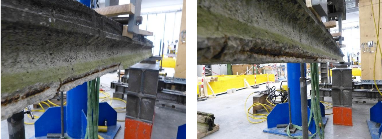
Figura 32 Condizioni del travetto prima della prova di flessione, con dettaglio dell'espulsione di copriferro in mezzeria
