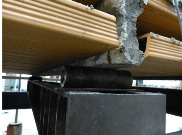
Figura 156 Condizioni dei travetti a inizio prova
