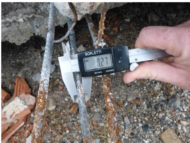
Figura 5 Particolare dell'armatura inferiore del travetto da 4.25 m
