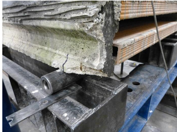
Figura 141 Condizione dell'appoggio sinistro del travetto 3 ad inizio prova
