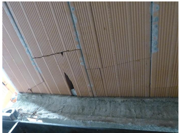
Figura 100 Condizioni delle tavelle dopo aver rimosso lo strato inferiore (probabilmente non dovuto alla prova ma al ritiro della cappa di rinforzo)
