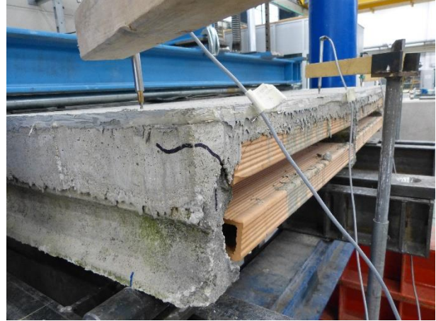
Figura 91 Condizioni dei travetti a inizio prova
