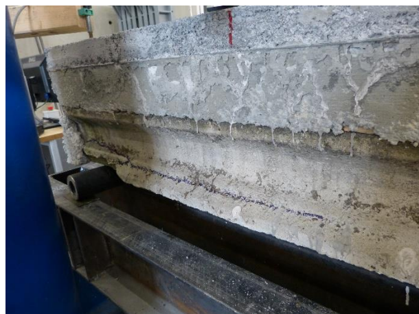
Figura 73 Dettaglio dell'appoggio destro del travetto 1
