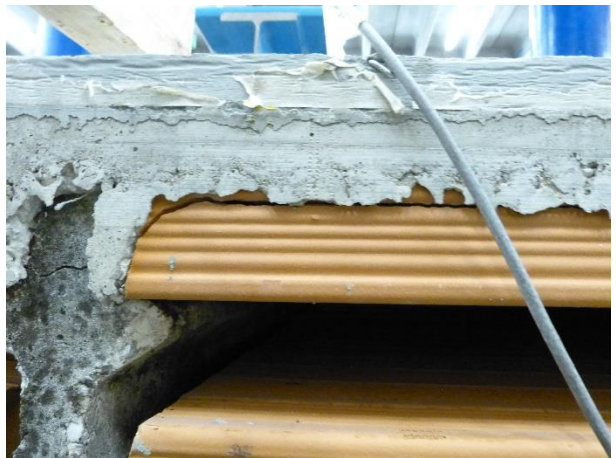
Figura 93 Condizioni delle tavole ad inizio prova (rottura per ritiro contrastato della cappa collaborante)
