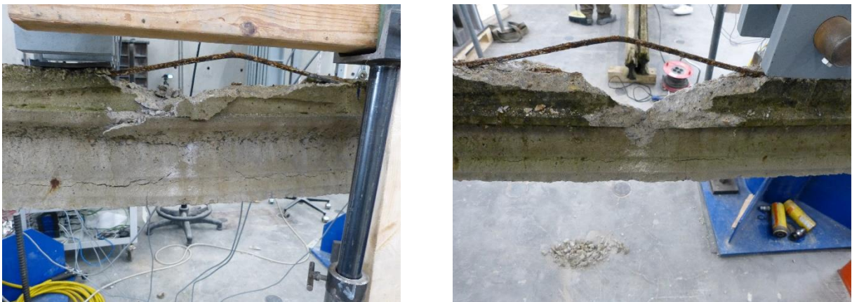
Figura 44 Condizioni del travetto dopo la prova di flessione
