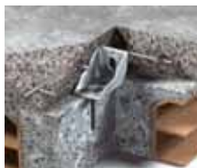
Solai in CLS Connettore Calcestruzzo D10
